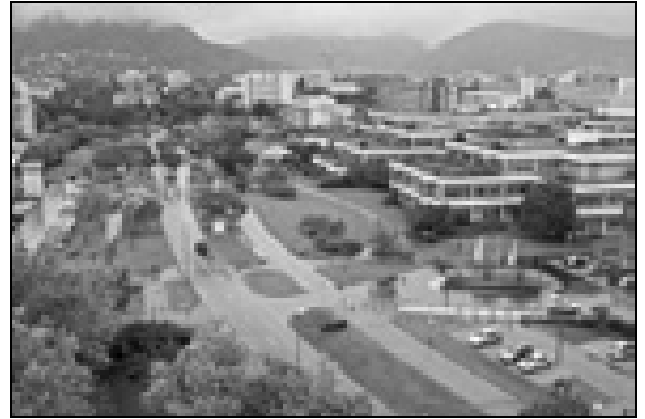
An dieser Stelle im Heidelberger Uni-Gelände "Im Neuenheimer Feld" soll in einigen Jahren die Straßenbahn fahren. (Foto: Stadt Heidelberg/Rothe)
