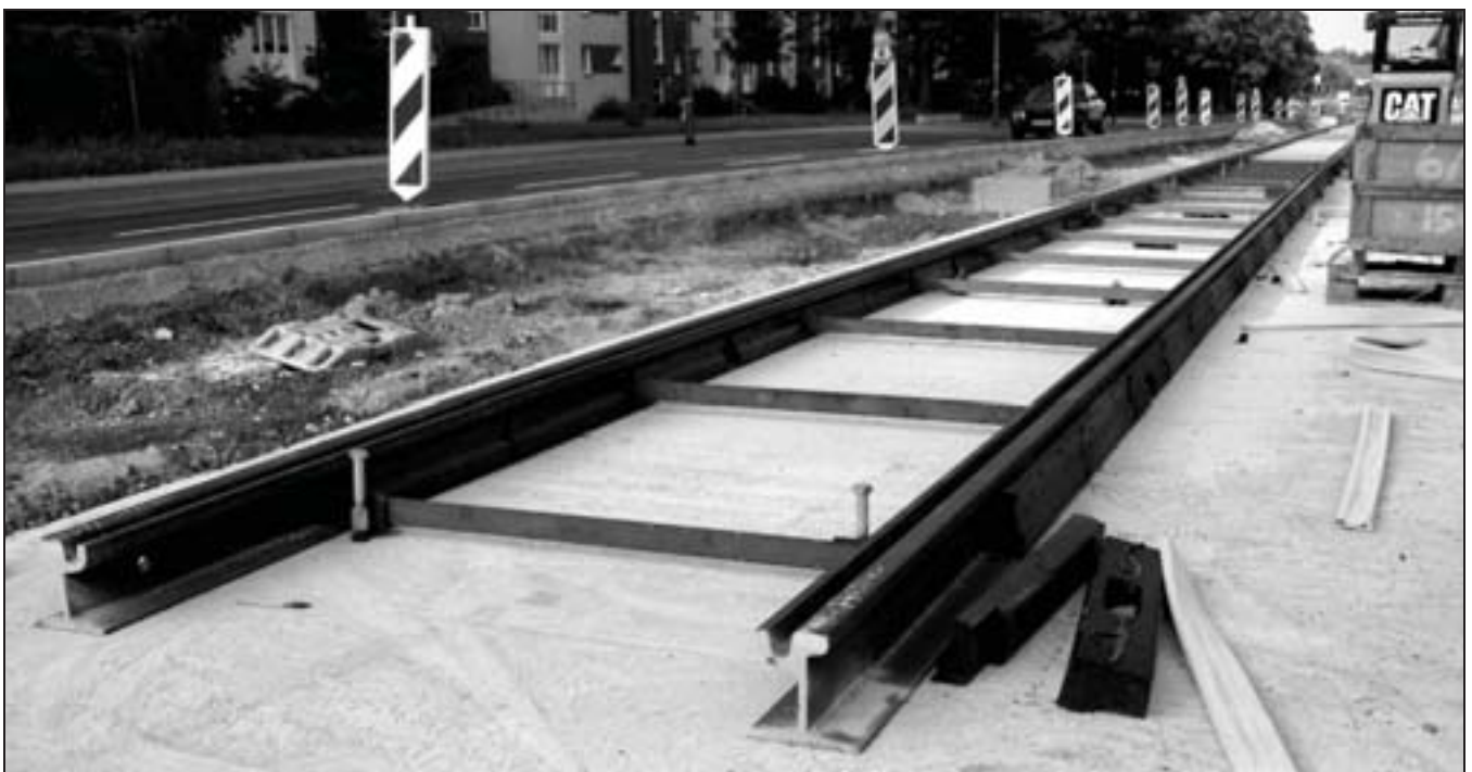
Feste Fahrbahn in der Friedberger Landstraße (Fotos: Thomas Schwemmer)
