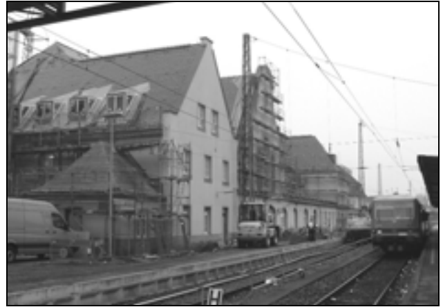
Der Bahnhof in Marburg wird saniert. (Foto: tk)
