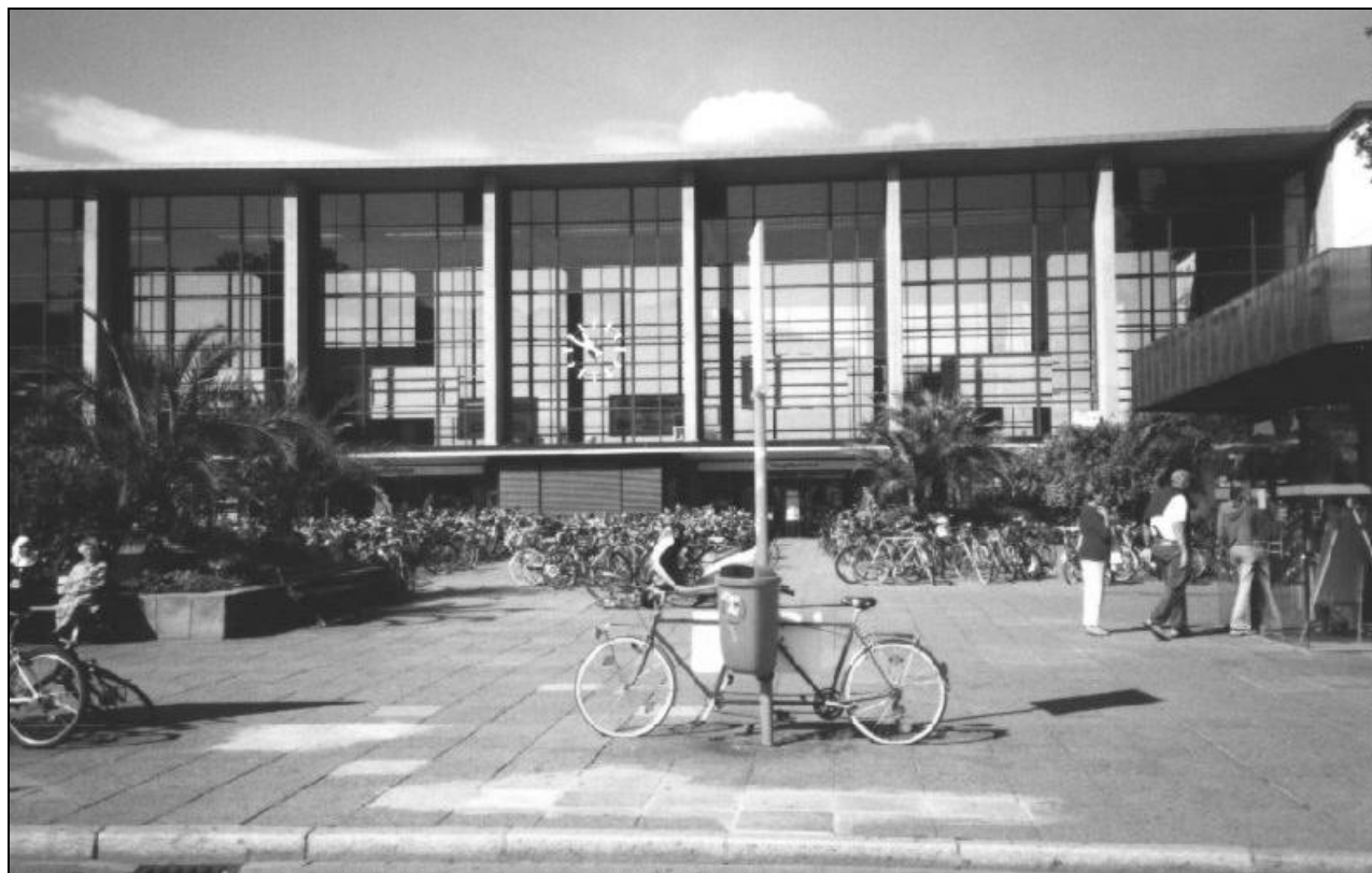
Die Haupthalle des Heidelberger Hauptbahnhofs
