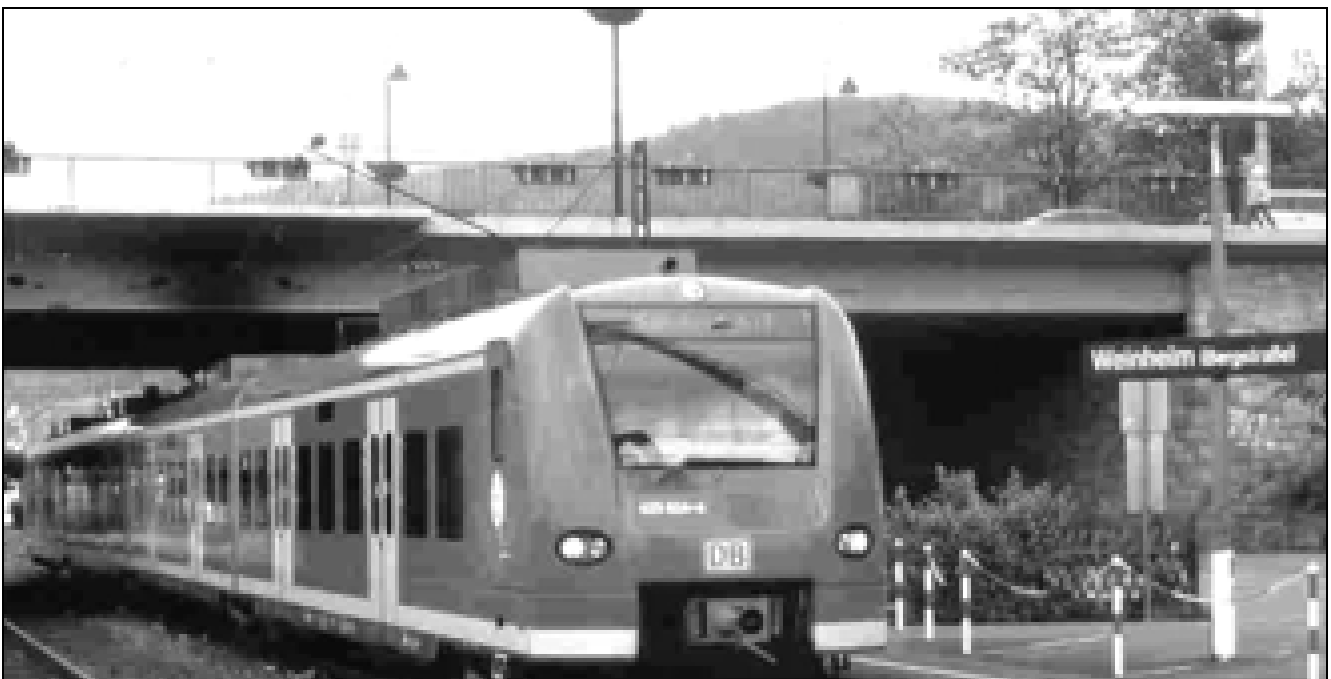
Auf dieser Brücke am Weinheimer Bahnhof soll (wieder) eine Haltestelle für die OEG-Stadtbahnlinie 5 Weinheim – Mannheim – Heidelberg entstehen. (Foto: Andreas Müller)
