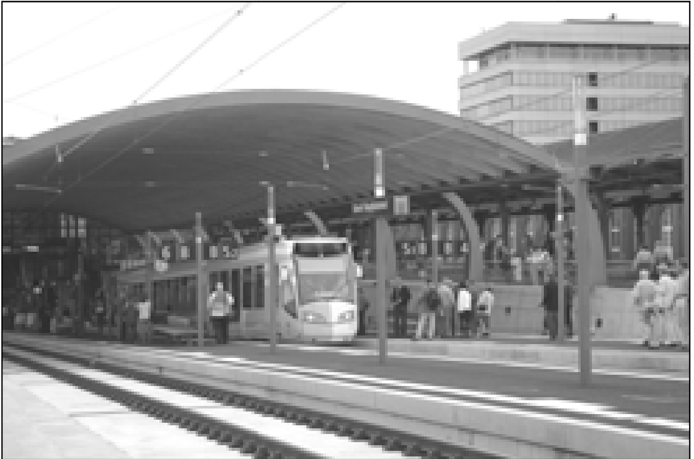
Der Tunnelausgang auf der Bahnsteigseite des Hauptbahnhof (Fotos: Wolfgang Schmidt)
