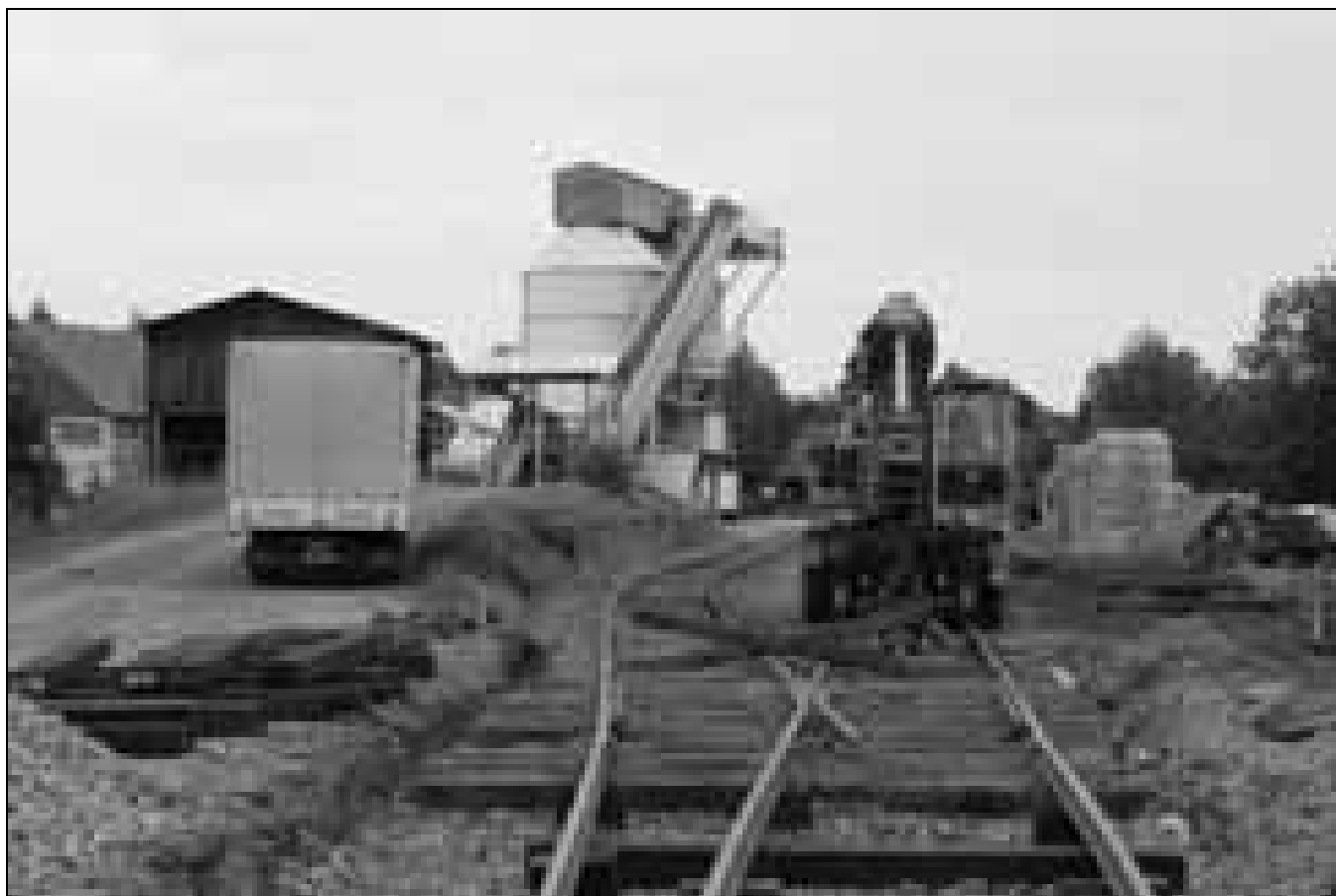
Gleisbauarbeiten in Groß-Bieberau (Foto: Joachim Theinert)
