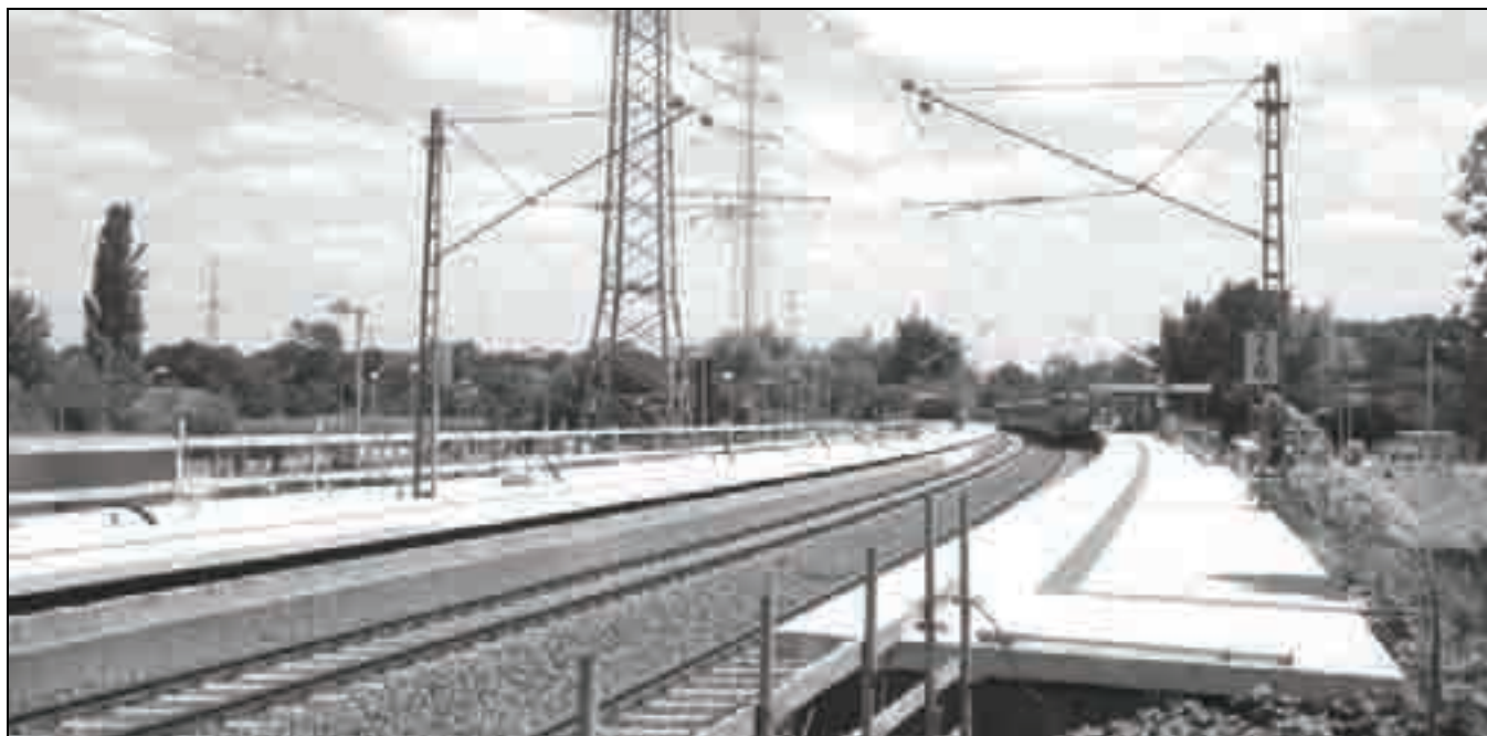
Umbau und Gleiserneuerung des Haltepunktes Eschborn Süd (Fotos: Wilfried Staub)
