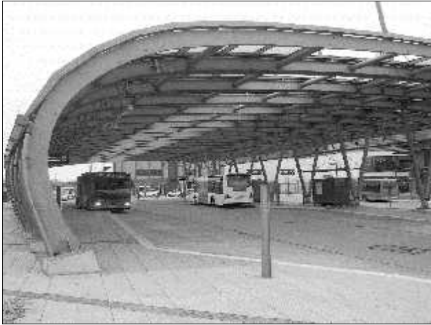
Blick unter das Vordach des Wetzlarer Busbahnhofs. (Foto: tk)
