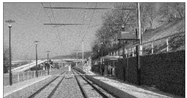
Ausbaustrecke der RNV-Linie 5 in Weinheim, hier am Haltepunkt Rosenbrunnen. (Foto: Michael Löwe)
