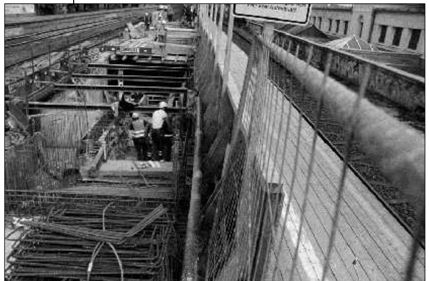
Bauarbeiten im Bahnhof Höchst. (Fotos: Wilfried Staub)
