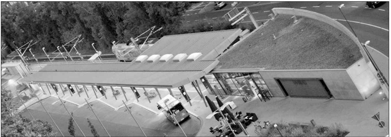
Luftaufnahme: Der 2009 neu gebaute Stadtbahnhof in Eschwege. (Foto: NVV)
