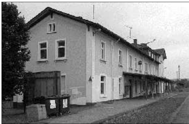
Bahnhof Lauterbach (Foto: Exakt)
